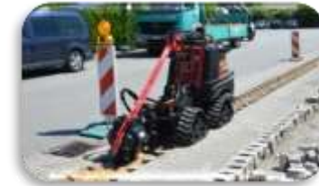
Verlegung im Vibrationseinzugsverfahren
